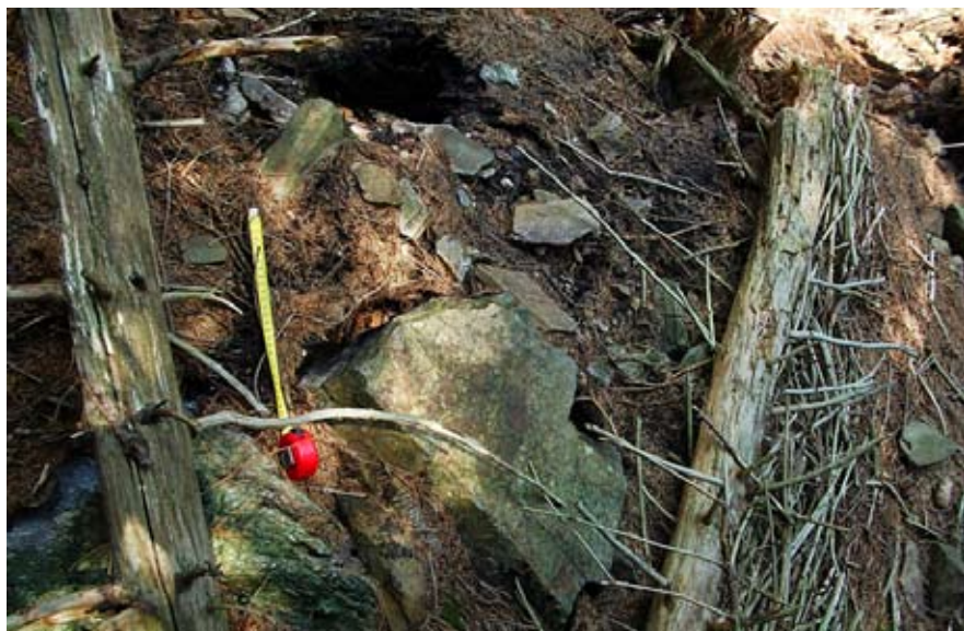
Fot. 3. Szczeliny tensyjne (z rozciągania) w pokrywach stokowych w pobliżu osuwiska na Średniaku (fot. K. Parzóch).
