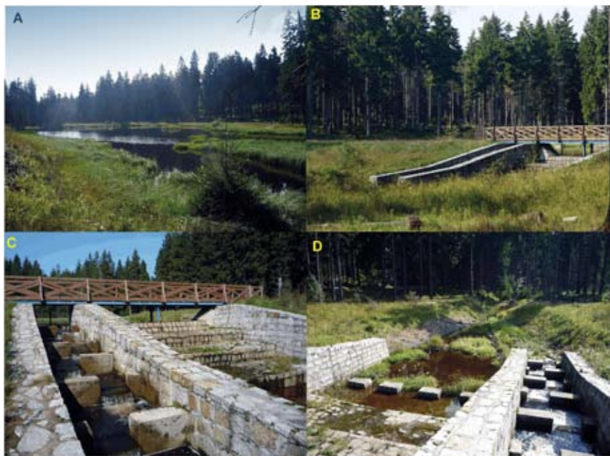
Fot. 2. Zbiornik małej retencji na Czerwonej Wodzie poniżej Karlowa: A – widok ogólny zbiornika; B – zapora ziemna; C – profil schodkowy zapory oraz przepławka dla ryb; D – niecka wypadowa zapory (fot. M. Witek).
