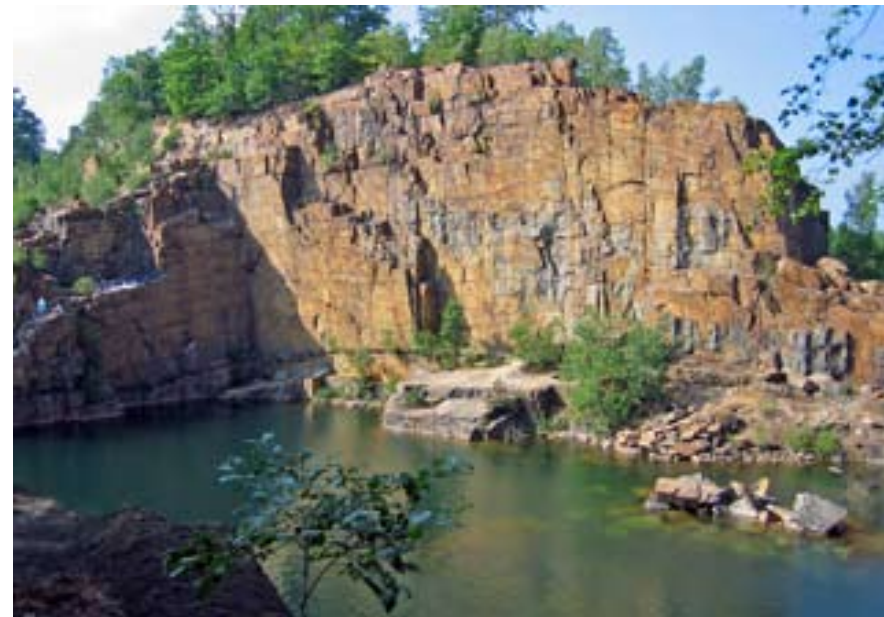
Fot. 18. Dawny kamieniołom Firstensteinbruch (fot. P. Migoń).
