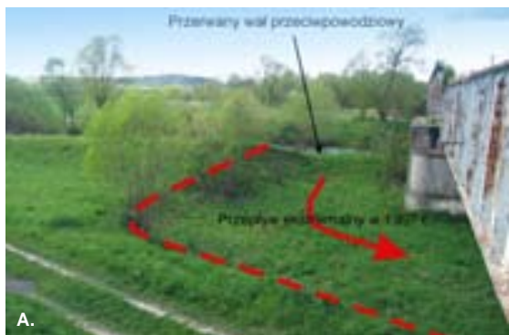
Fot. 7. Na sztucznych przeszkodach w korycie procesy erozyjne ulegają nasileniu, głównie przy bocznych filarach mostów (fot. A. Latocha).
