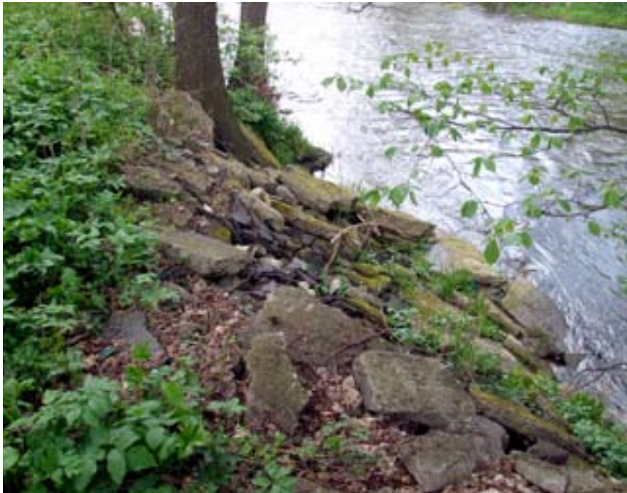
Fot. 4. Nasyp antropogeniczny (gruz betonowy) jako umocnienie brzegu (fot. A. Latocha).
