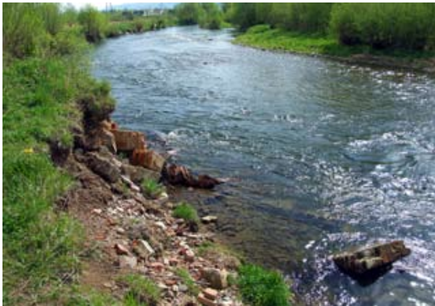
Fot. 3. Fragmenty zniszczonej dawnej obudowy koryta odsłaniają się w wyniku erozji brzegu (fot. A. Latocha).
