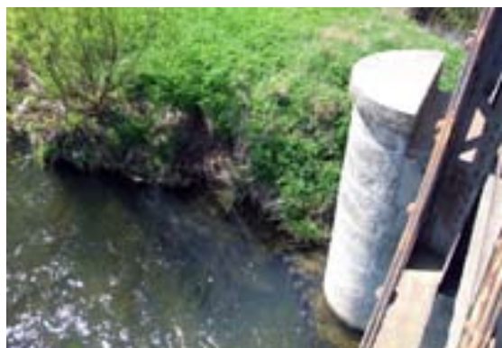
Fot. 7. Na sztucznych przeszkodach w korycie procesy erozyjne ulegają nasileniu, głównie przy bocznych filarach mostów (fot. A. Latocha).
