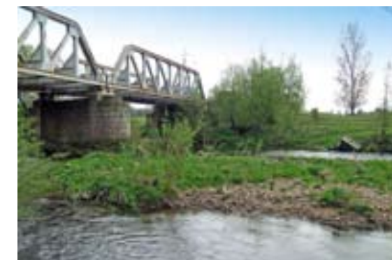
Fot. 10. Akumulacja żwirowo-piaszczysta w postaci łachy śródkorytowej powstałej jako cień sedymentacyjny za filarem mostu kolejowego (fot. A. Latocha).
