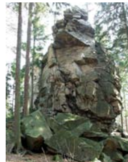
Fot. 2. Południowo-zachodnia ściana muru skalnego Trzech Baszt, założonego w obrębie powierzchni szczytowej Trojaka. U podstawy ściany widoczne bloki skalne pochodzące z rozpadu skałki wzdłuż powierzchni nieciągłości (A) (fot. A. Sobczyk).
