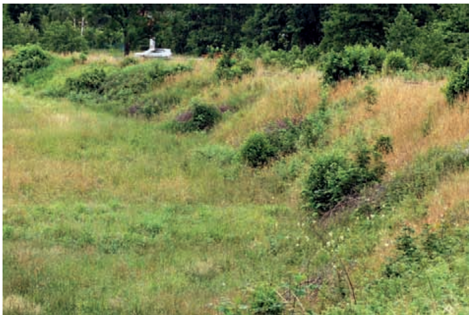
Fot. 3. Południowo-zachodnia część nasypu kolejowego oraz fragment łąki wilgotnej (fot. A. Malkiewicz).
